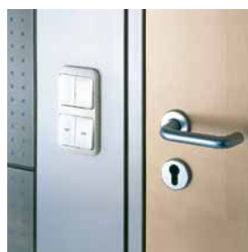
Technikmodul: Zur Integration von Versorgungs- leitungen. Die Wand kann in diesem Bereich beidseitig pro- blemlos geöffnet werden.
